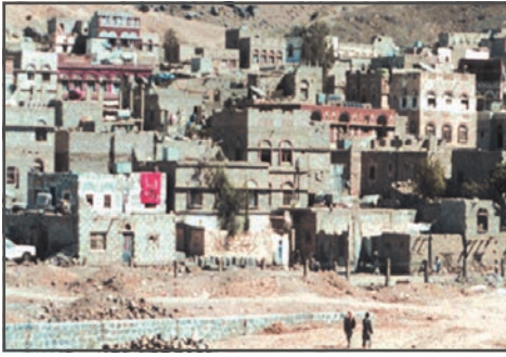
شكل ( ١ ) حي سكني مبني بطريقة عشوائية
